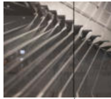
ILUMINACIÓN EN ESCALERA
