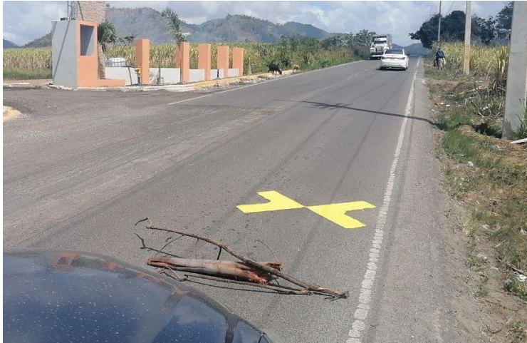
Figura 3: Marcado de pintura en un punto de control (Fuente: De nuestra autoría)
