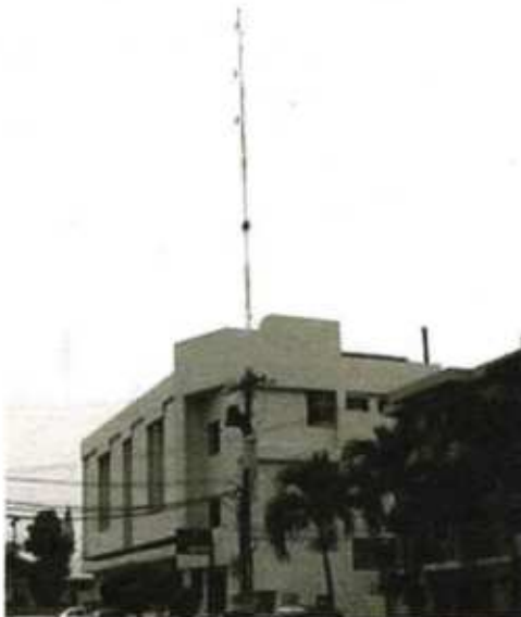
Fig. 10 Antena sobre edificio habitado
