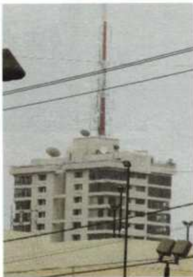
Fig. 24 Antena sobre torre apartamentos.
