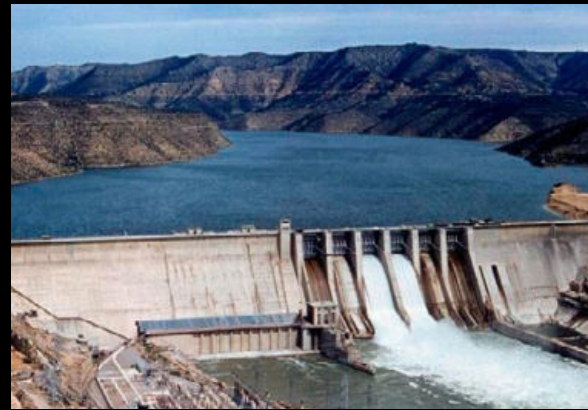
PRESA DE MONCIÓN
