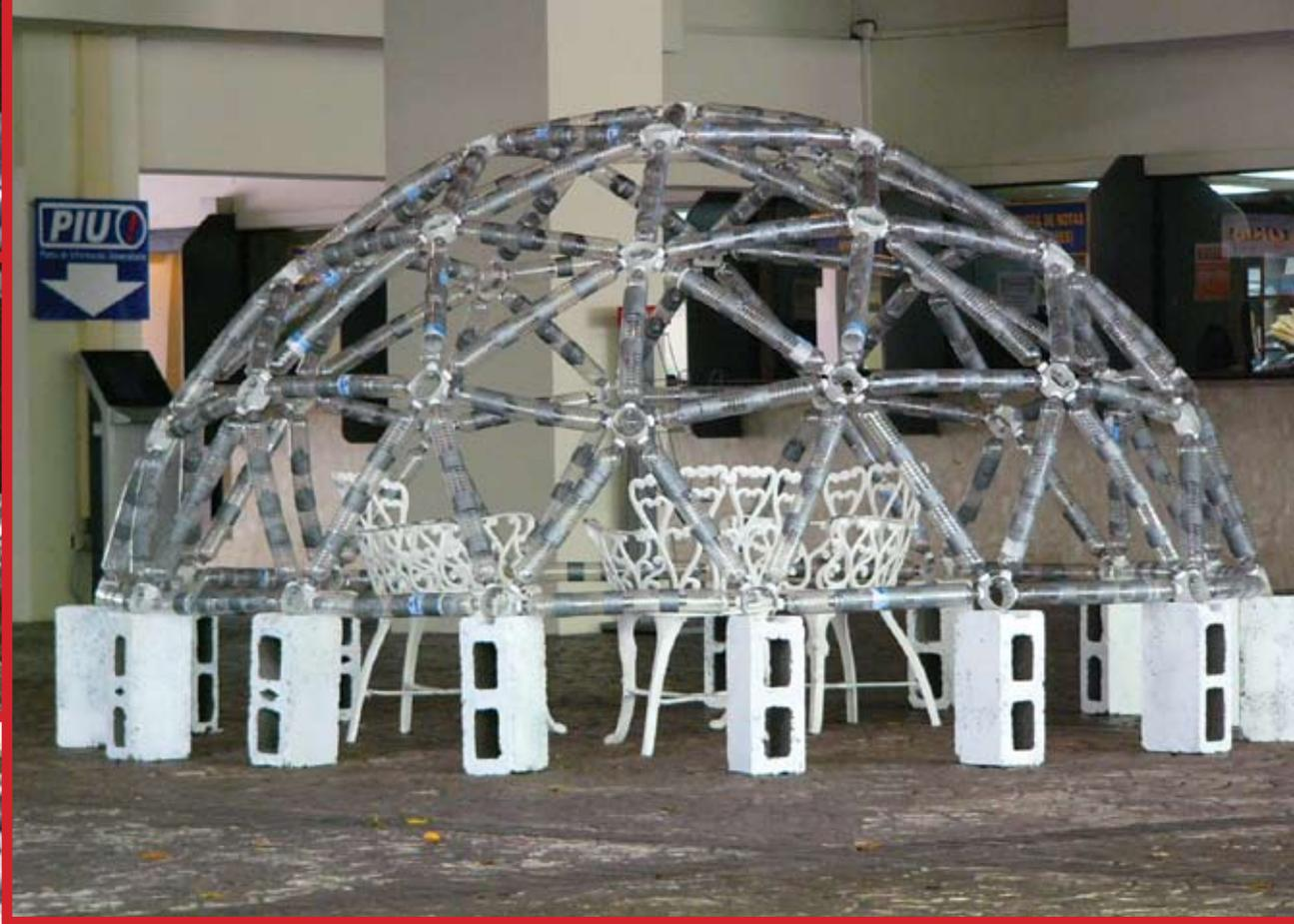
Al final del semestre, Paloma Arias, Kumiko Kasahara, Rafael Abreu y yo y un servidor construimos un domo geodésico de  $1/3$  de esfera, hecho de miembros cilíndricos obtenidos al ensamblar botellas fondo con cuello. El domo tenía un diámetro de 3.5 mts y una altura de 2 mts.
