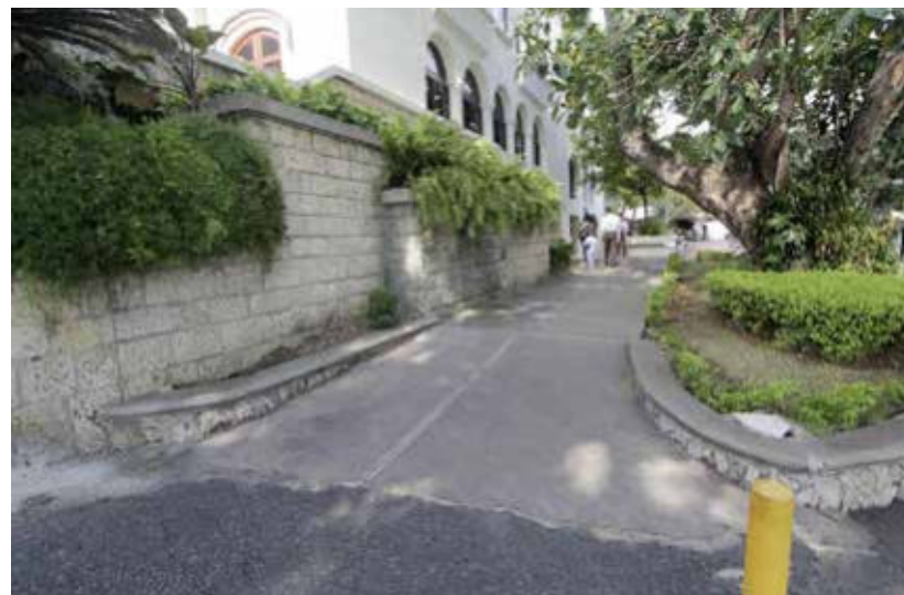
Rampas de acceso
