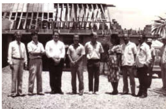
Ing. Hazoury supervisa obras en construcción
