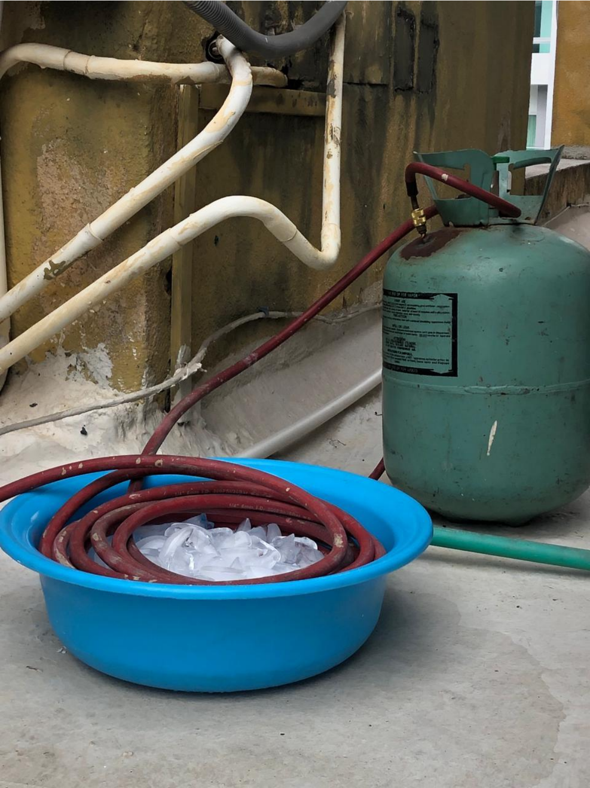
Anexo 39: Regulación de la tubería que conduce el gas al tanque
