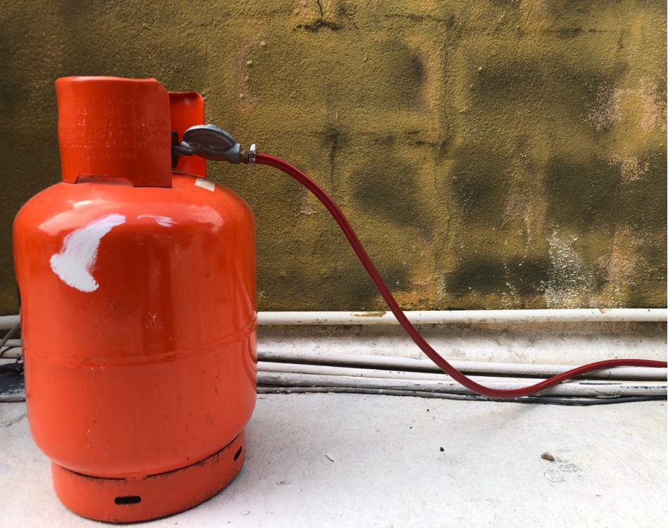
Anexo 15: Tanque de gas conectado al regulador
