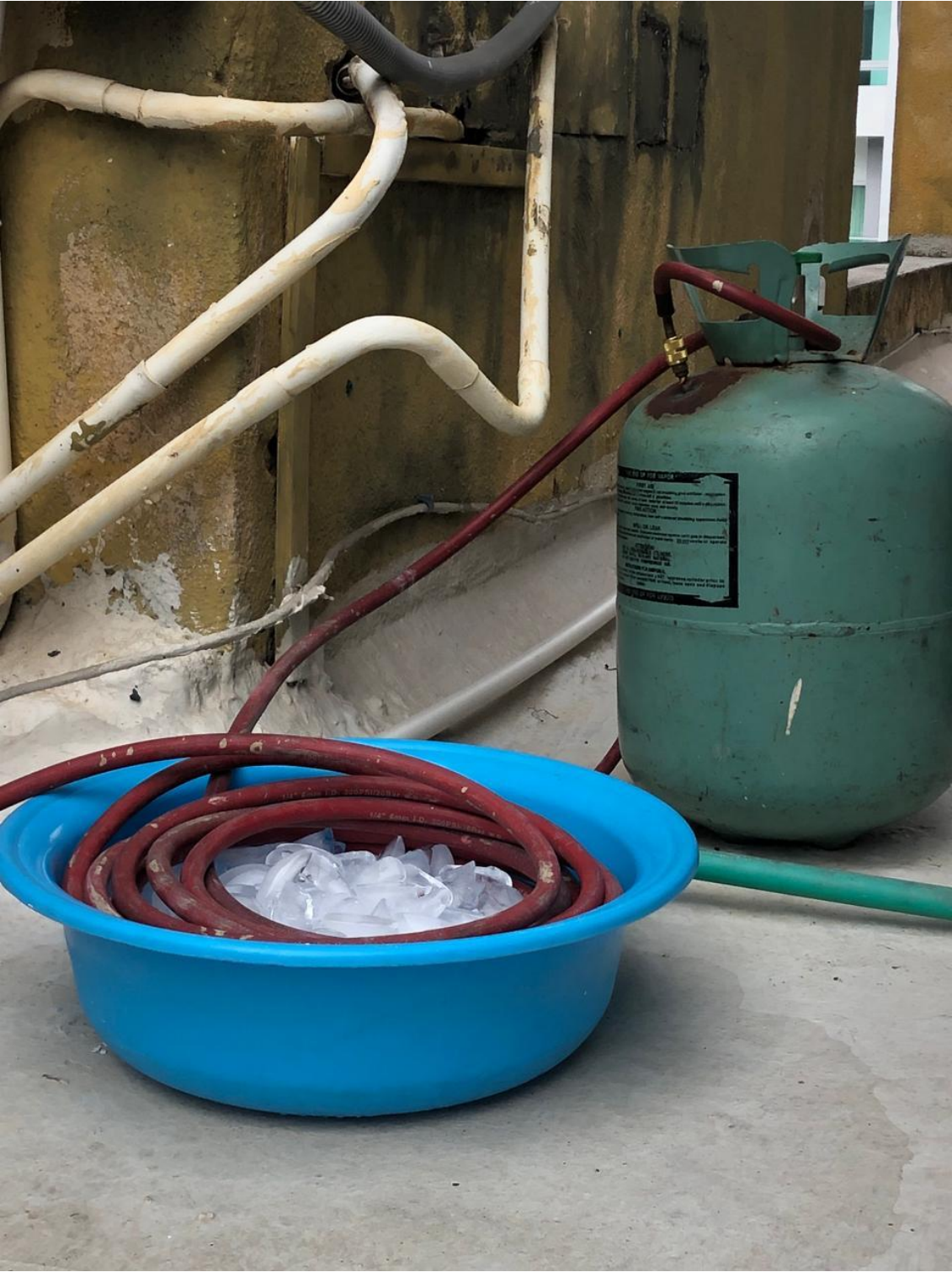
Anexo 25: Montaje del sistema de enfriamiento
