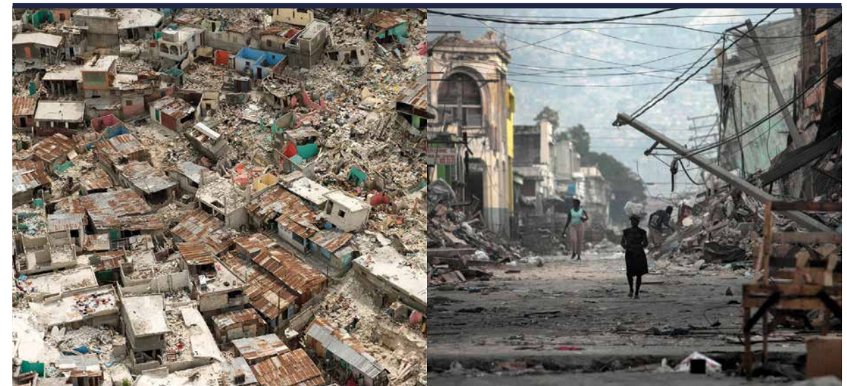
Fotos 3 and 4: Daños ocasionados por el sismo de Haití en el 2010 12
