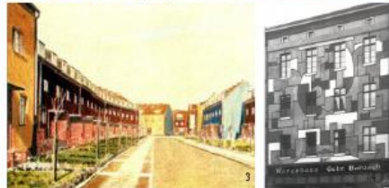
1. Fachada de las viviendas de la colonia Falkenberg en Berlín Grünau, B. Taut, 1913-1934. 2. Siedlungen Onkel Tom's Hütte, casas en hilera Argentinische Elise, B. Taut, Zehlendorf (Alemania), 1926-1931. 3. Postal coloreada de las viviendas de la colonia Falkenberg en Berlín Grünau, B. Taut, 1913-1934. 4. Casa coloreada en Peter Strasse 22, Oskar Fischer, Magdeburgo, 1919-1921.
