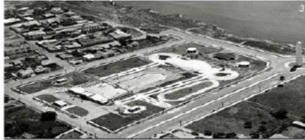
1. "Mercado Municipal San Pedro de Macorís" (1912), Antonin Nechodoma. 2. "Parque Ramfis" (1937), Guillermo González 3. "Parque Ramfis" (1937), Guillermo González
