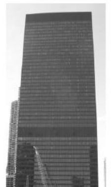
Los materiales, aluminio negro y vidrio teñido gris, se utilizaron conjuntamente para crear la piel uniforme.
