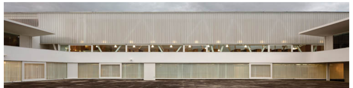
-Biblioteca Pública y Archivo Regional Luís da Silva Ribeiro / Inês Lobo Arquitectos. Imagen obtenida del portal Archdaily.
