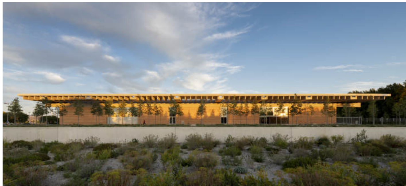
-Museo Narbo Via, por Foster + Partners. Ejemplo de vegetación como estrategia de control solar. Imagen obtenida del portal Archdaily
