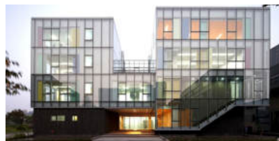
-Paju Book City / Stan Allen Architect. Imagen obtenida del portal Archdaily
