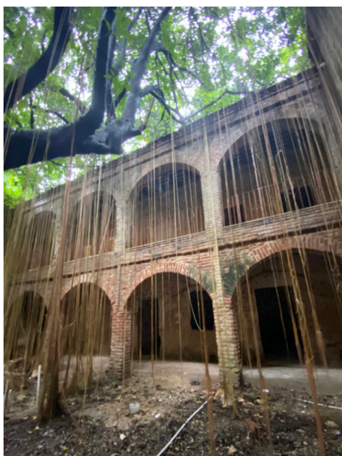
VISTA DEL PATIO PRIMER NIVEL
