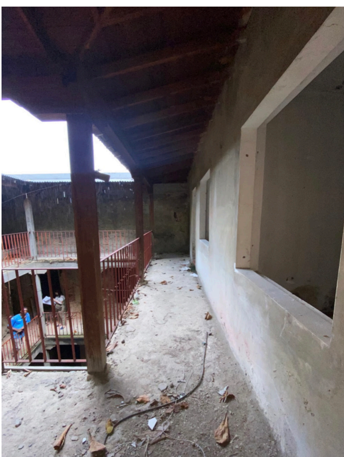
VISTA DE ANEXO TERCER NIVEL
