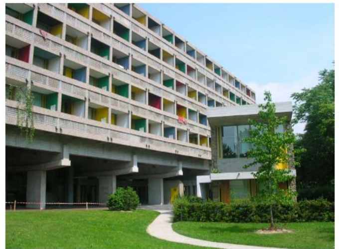
Unidad Habitacional de Marsella, Le Corbusier. 1952.
