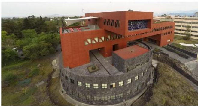
Edificio de Postgrado en Economía, UNAM
