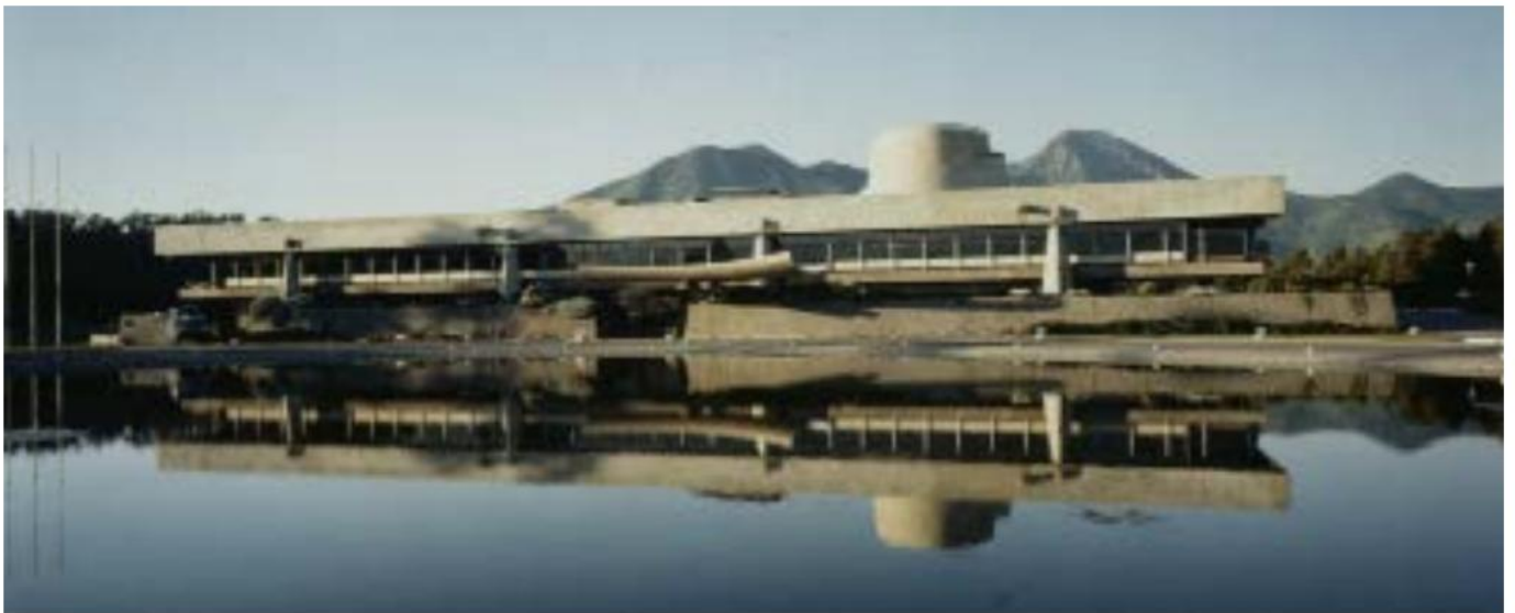
Edificio de la Comisión Económica para América Latina y El Caribe de las Naciones Unidas (CEPAL), Santiago, Chile, 1962-1966.
