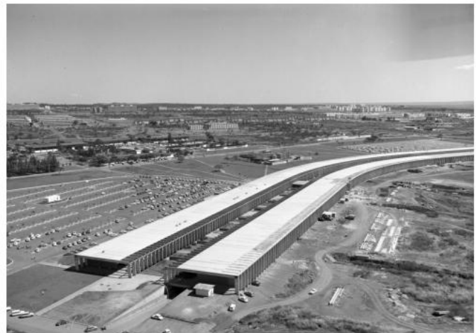
Vista aérea del Instituto Centro de Ciências, momento de su construcción.
