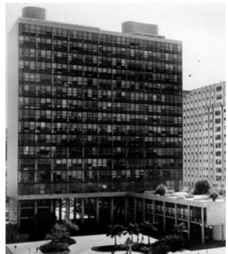
Edifício Gustavo Capanema, Lúcio Costa. Rio de Janeiro, Brasil, 1945.
