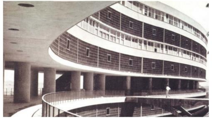
Complejo Residencial Pedregulho, Río de Janeiro
