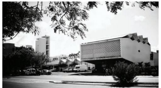
Cuartel de Bomberos, Santiago de los Caballeros, 1976
