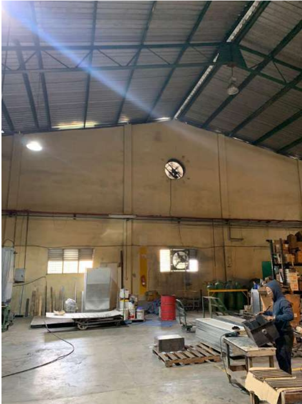
Anexo 13. Zona de Reparación
