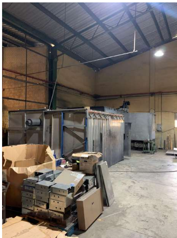
Anexo 12. Zona de Pintura (Izquierda) y Secado (Derecha)
