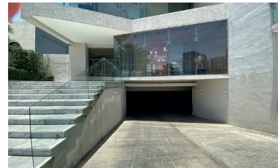
1. VISTA EXTERIOR SEMI-SÓTANO
