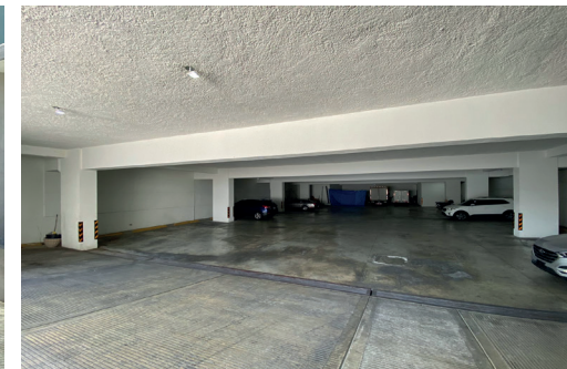
2. VISTA INTERIOR SEMI-SÓTANO
