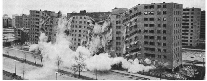
Demolición Pruitt-Igoe, San Luis, Misuri, 1972.
