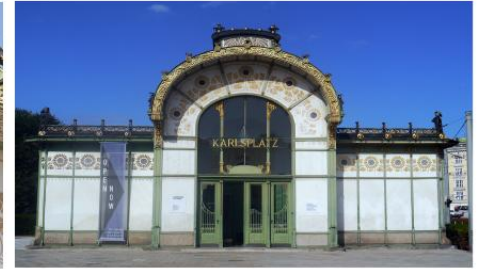
Karlsplatz Stadtbahn Station, Otto Wagner
