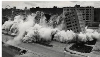
3) Destrucción viviendas Pruitt-Igoe, 1972
