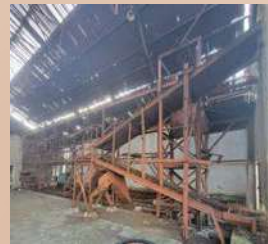
Estructura de acero oxidado con potencial de reutilización
