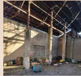
Restauración de columnas con encamisado en concreto
