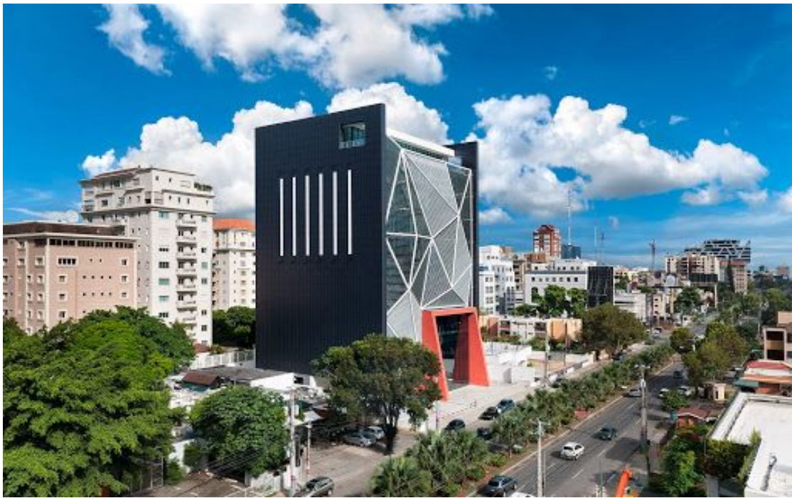
Figura 7.2.1 Imagen de edificación
