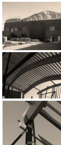
1 Vista da cobertura em madeira sendo construída.
