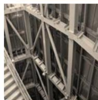
4 Ondulações em aço inox revestindo a caixa prismática retangular do auditório.
